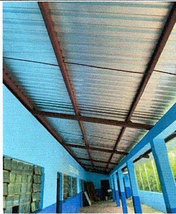
Foto 3: En proceso de Ampliación
