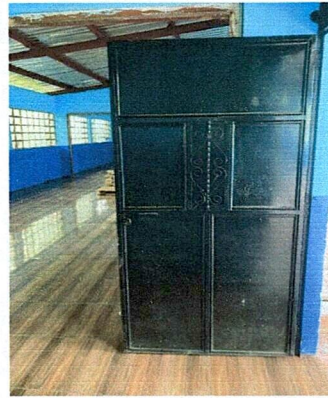
Foto 4: Mantenimiento y reparación de puertas.
